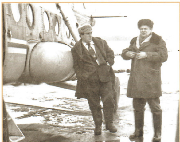
Прибытие главного инженера Главка на фонтан
